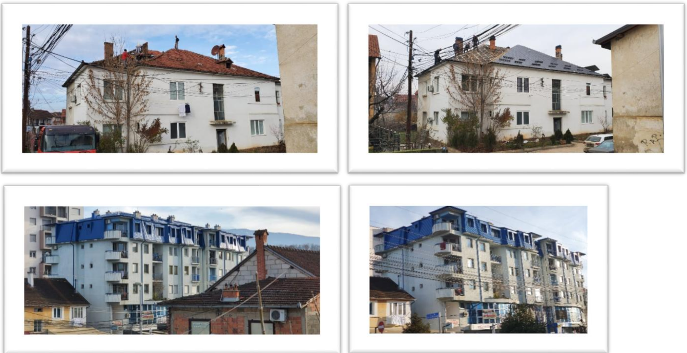
Foto 11. Gjatë realizimit të punimeve në pullazet e banesave kolektive
