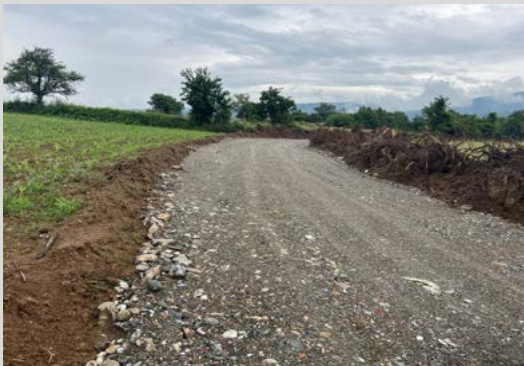
Gjatë realizimit të projektit “Ndërtimi i infrastrukturës rrugore në Bujqësi dhe Pylltari” Foto gjatë realizimit të punimeve në fshatin Vraniq
