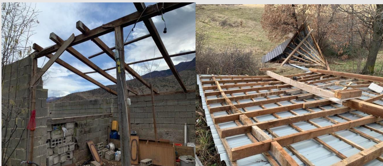
Disa fotografi nga inspektimet nëpër objektet shkollore Kalldaja e Nxemjes dhe hidrantet në shkollë
