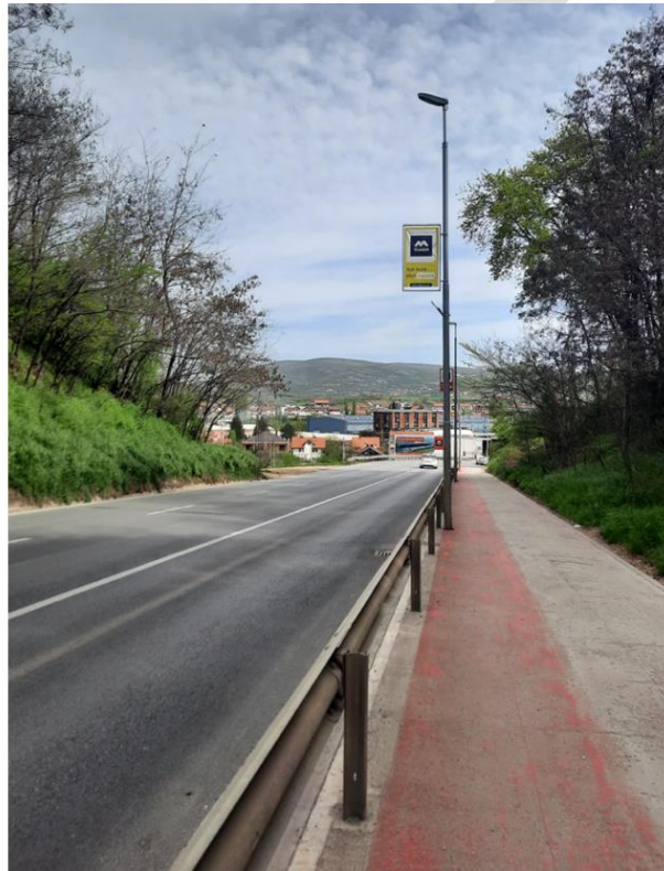
Fig.83. Shtigjet për çiklist dhe trotualet për këmbësorë përgjatë rrugës nacionale N9
