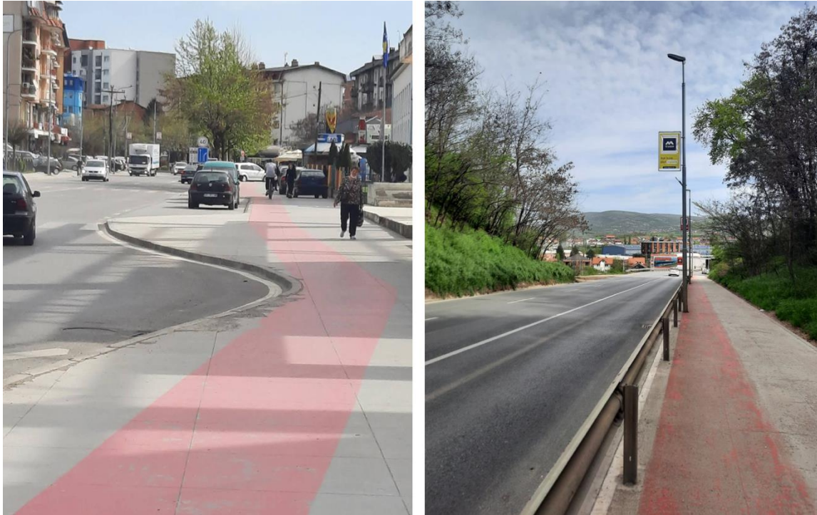
Fig.33. Shtegu ekzistues për çiklist përgjatë rrugës nacionale N25
