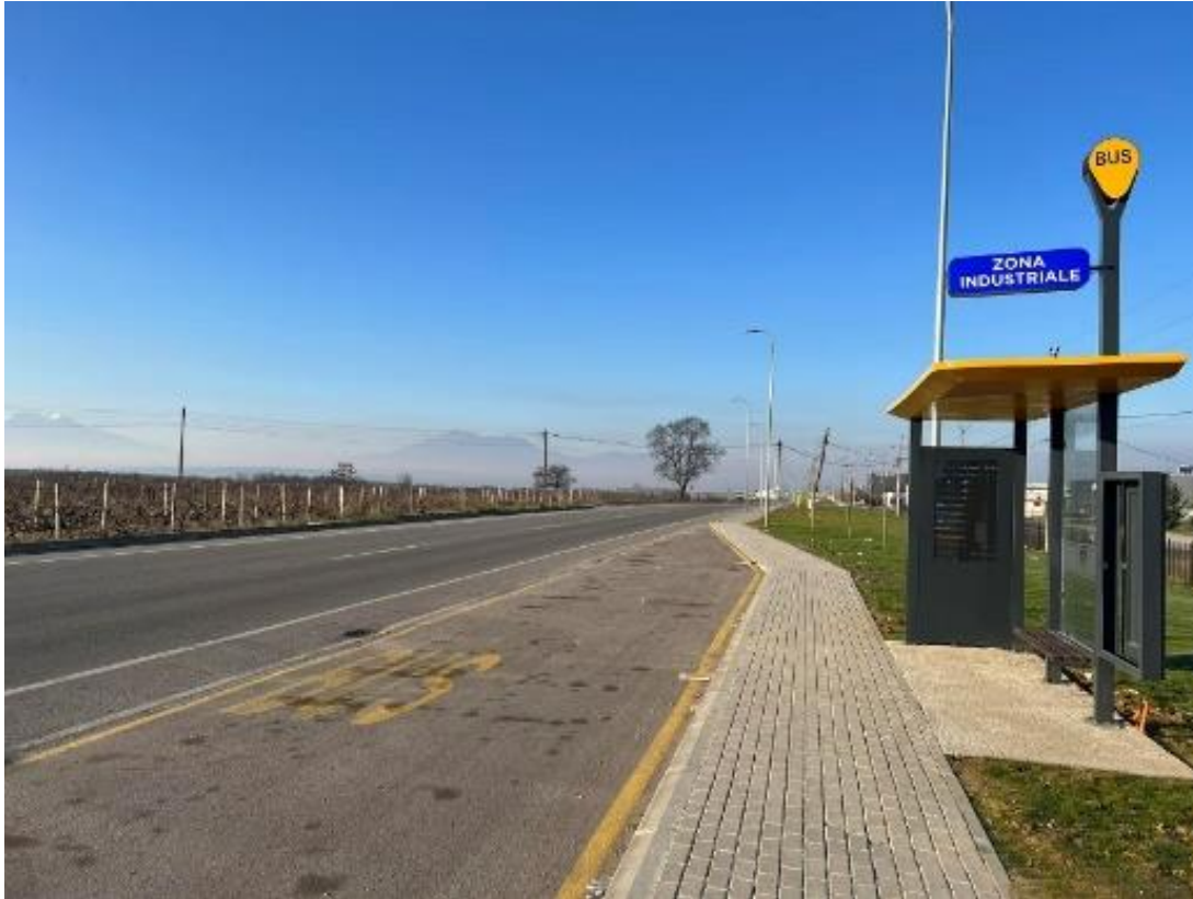
Fig. 46. Gjendja ekzistuese e njëjës prej vend-ndaljeve të autobusëve në Komunën e Suharekës
